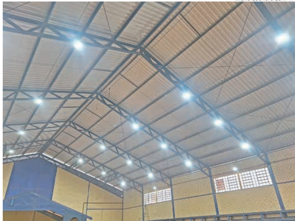
Área interna já recebeu pintura e ampliação de iluminação
