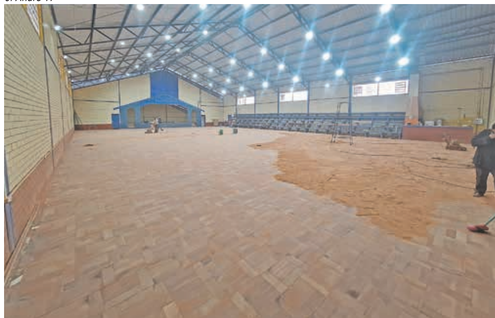
Piso está sendo lixado para posterior pintura
