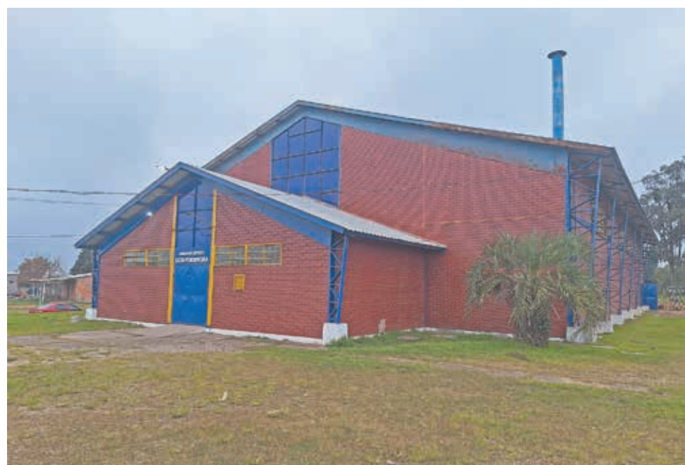
Parte externa do ginásio já tem 70% da pintura concluída
