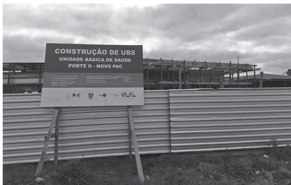
Obra segue avançando conforme o cronograma
