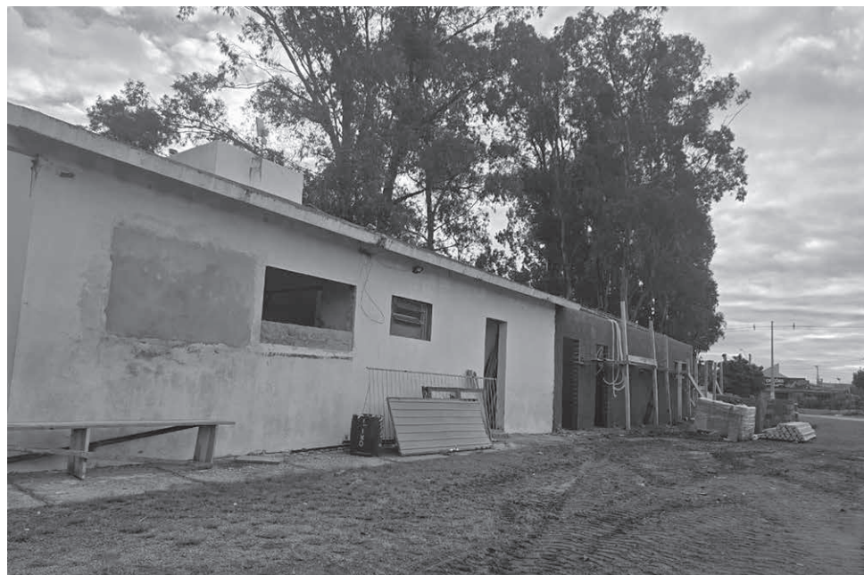
Vestíários femininos estão sendo construídos pela Prefeitura de Candiota no campo Tarumã, na sede do município
